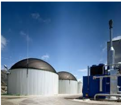
Imm. 36: impianto biogas
